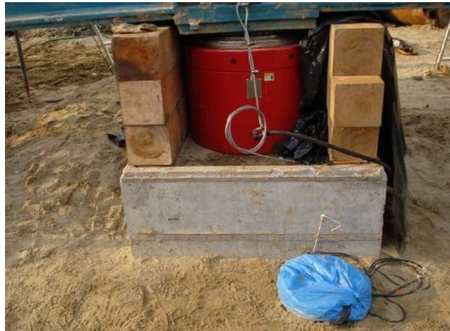
Figura 14. Montagem do macaco hidráulico.
