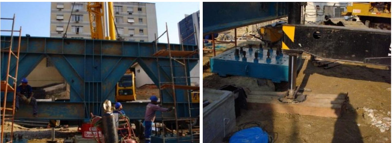
Figura 12. Montagem da estrutura de reação.
