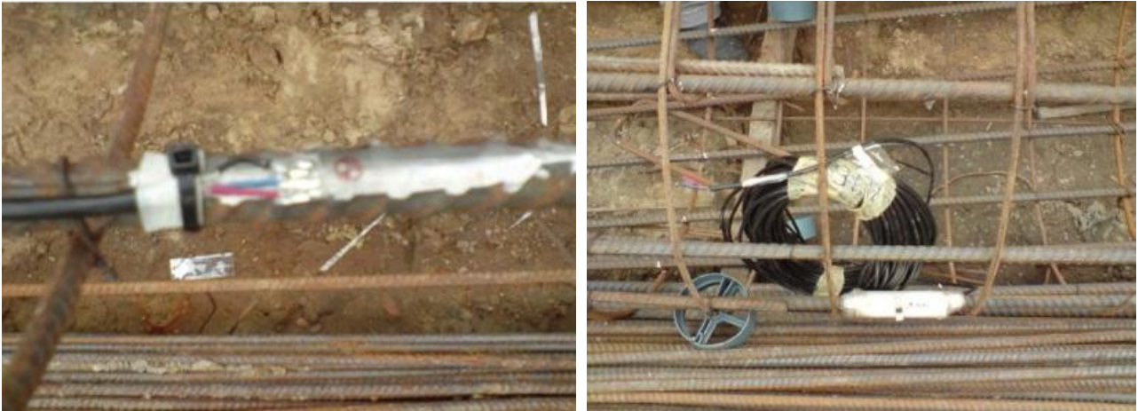
Figura 7. Detalhe do strain gage ; instalação do strain gage na armadura.
