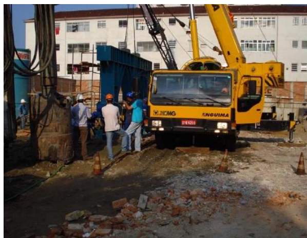
Figura 13. Montagem da estrutura de reação.
