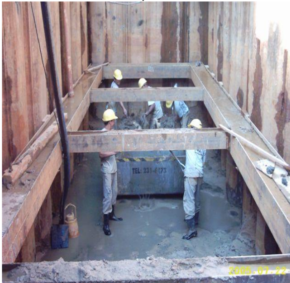
3. Vista Interna a -5,50 abaixo do rio
