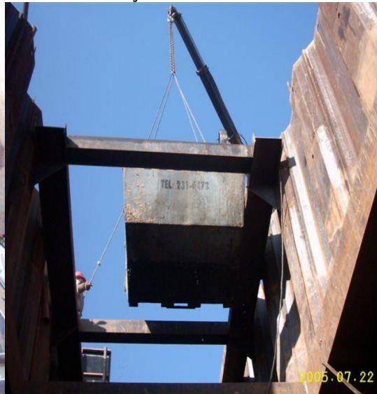
4. Vista remoção de terra.
