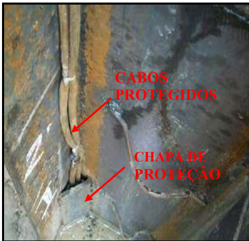
Figura 10 – Detalhe da chapa de proteção
