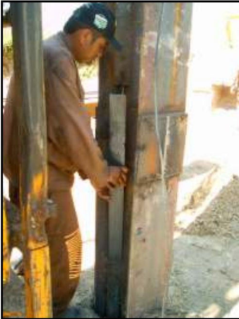
Figura 14 – Solda das chapas de proteção na região da emenda dos perfis
