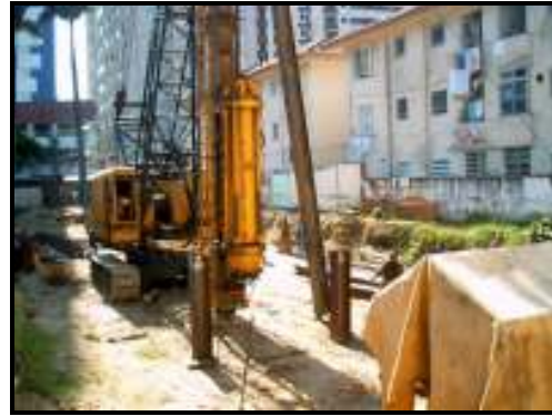
Figura 11 – Vista do Bate-estacas
