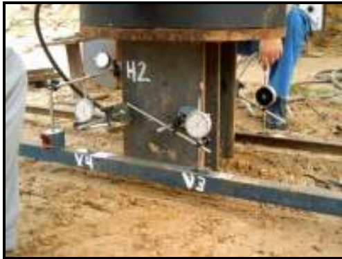
Figura 17 - Defletômetros instalados no topo da estaca.
