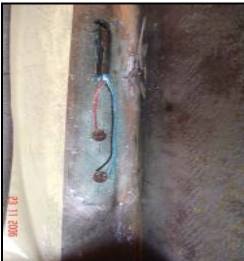
Figura 06 – Strain Gages instalados na alma do perfil
