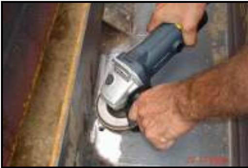
Figura 05 – Preparo da superfície para instalação dos “strain gages”.
