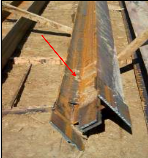
Figura 09 – Vista da chapa de proteção
